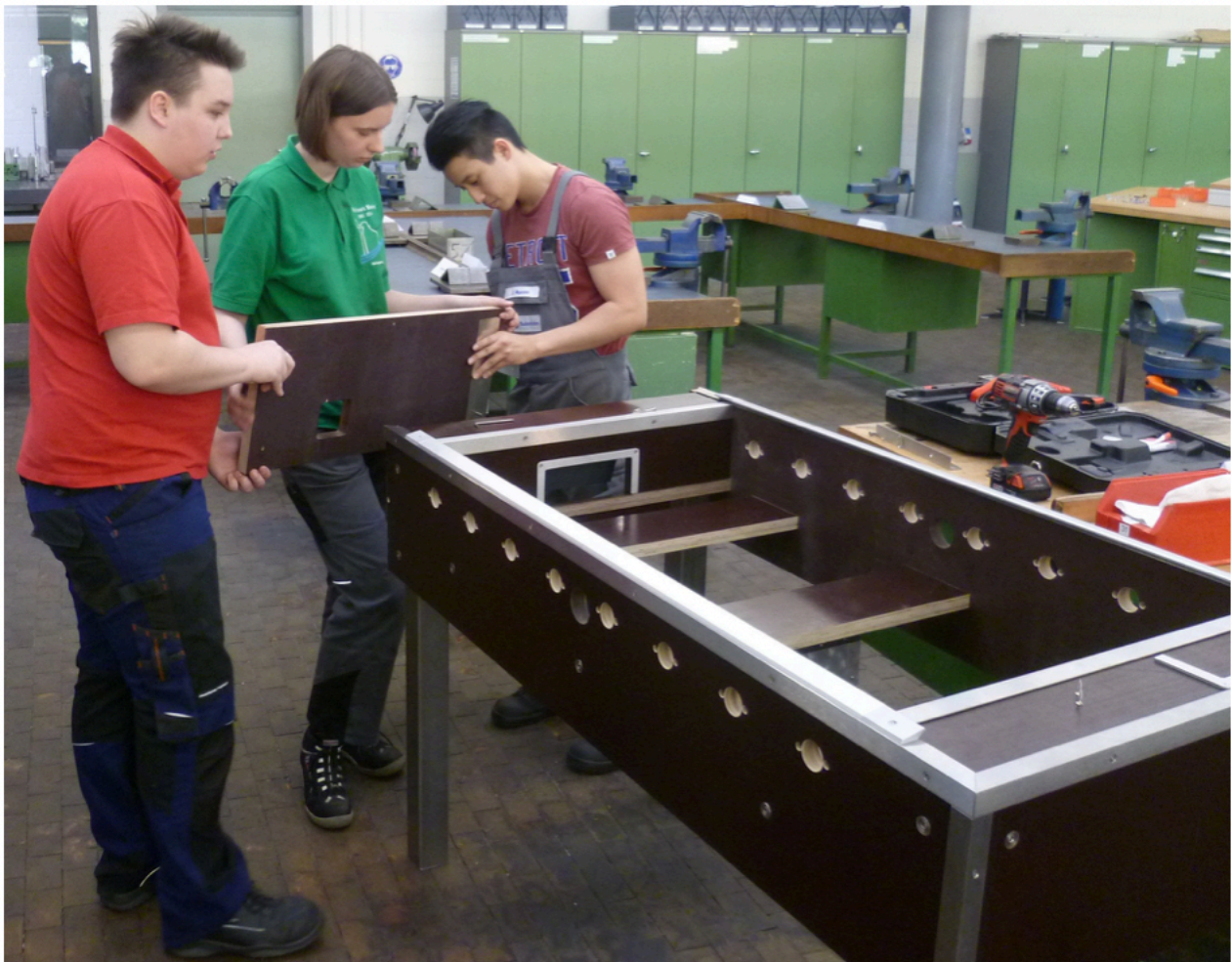
Exaktes Fertigen ist unerlässlich: Auszubildende fügen ein Seitenteil ein.
